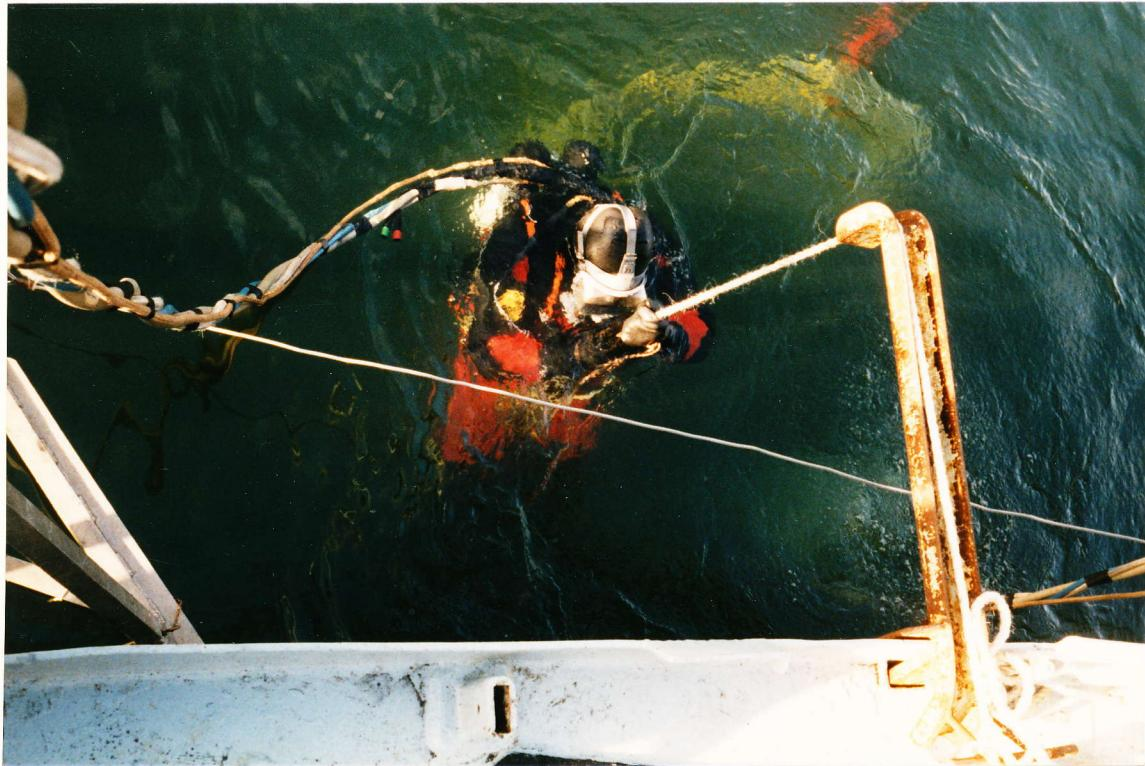
Slangedykker hænger i bundtovet og venter på dykkerlederens tilladelse til at forlade overfladen og derved starte dykhertiden (der bruges stopur).
